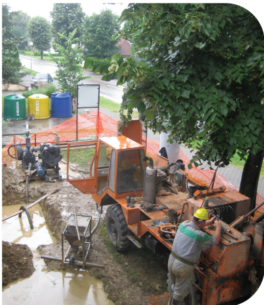
Slika 5. Izvođenje radova na ugradnji sistema podzemne toplotne pumpe, objekat "Dom mladih" u Srpcu
